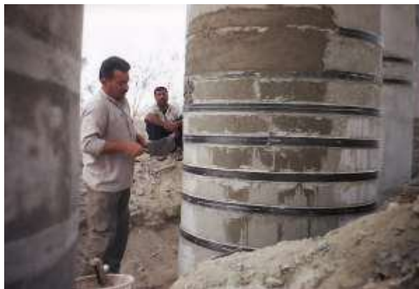
استفاده از لمینیت الیاف کربن در فرآیند مقاوم‌سازی پایه‌های پل‌های راه‌آهن محور بافق-بندرعباس
