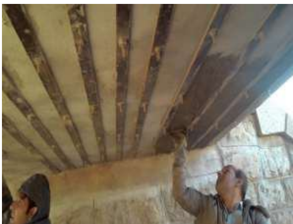
مقاوم‌سازی دال پل‌های راه‌آهن محور قم به کاشان با استفاده از تسمه فلزی
